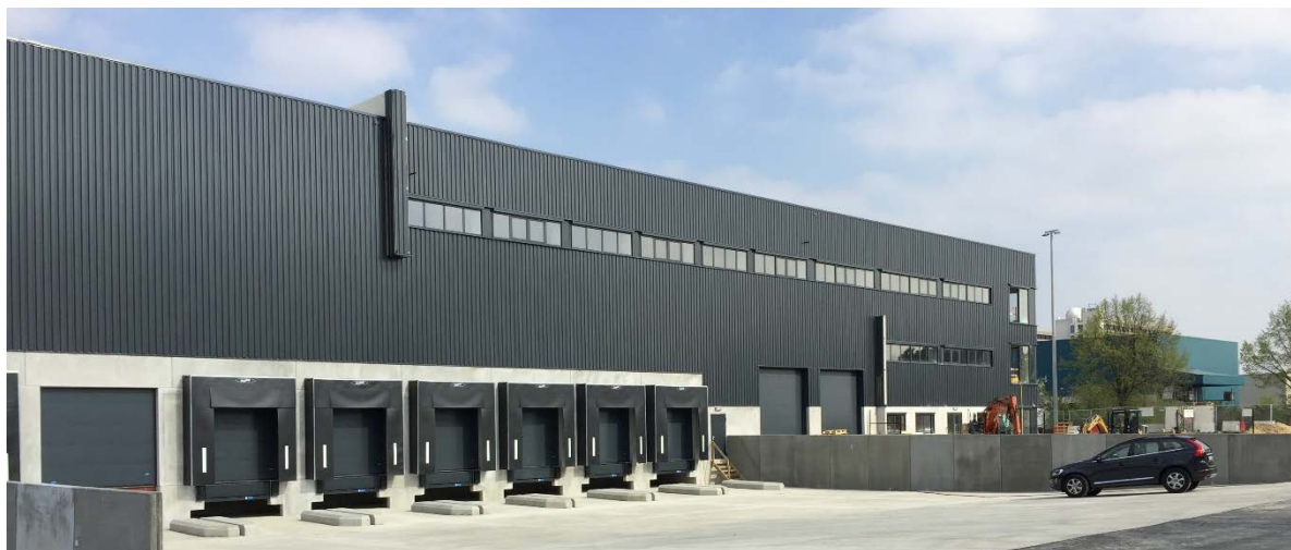
Montea «Space for Growth» -Site Saco Groupair (BE)
