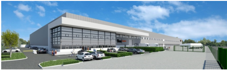
Montea «Space for Growth» - site Oss (NL)
