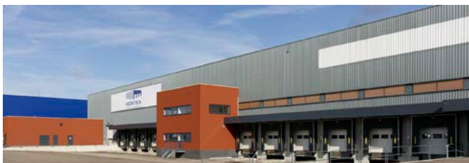
Montea «Space for Growth» - Site Puurs Schoonmansveld 28
