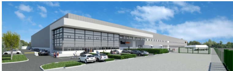
Montea «Space for Growth» - site Oss (NL)
