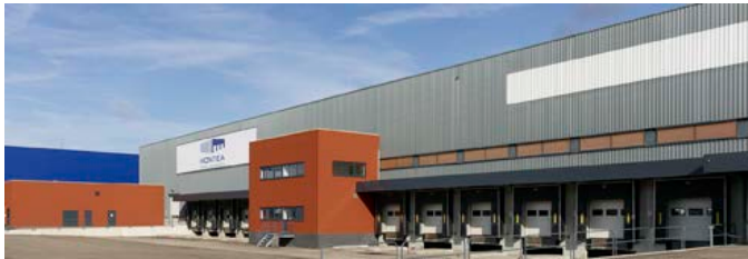
Montea «Space for Growth» - Site Puurs Schoonmansveld 28
