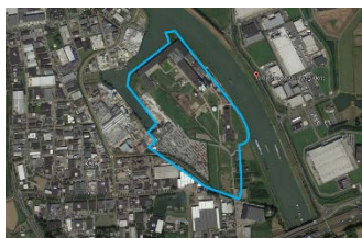
Photo aérienne: Terrain d'environ 48 ha - Tiel (NL)
