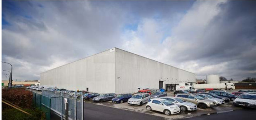
Montea «Space for Growth» - site Erembodegem - Alost (BE)
