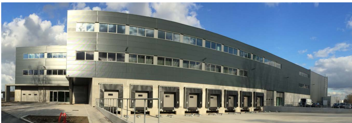
Montea “Space for Growth” - Erembodegem site, Waterkeringsstraat (BE)
