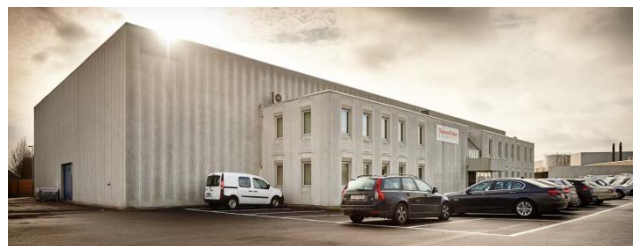
Montea «Space for Growth» - Site Erembodegem - Unit 8 (BE)
