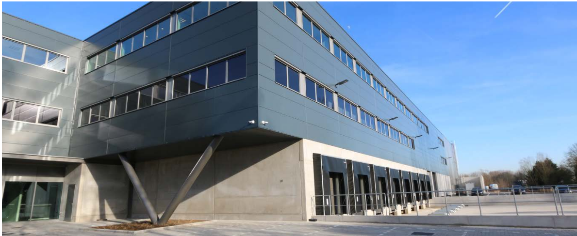
Montea « Space for Growth » - Site d'Erembodegem, Waterkeringsstraat (BE)
