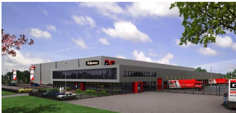
Montea « Space for Growth » - Site de Tilburg (NL)
