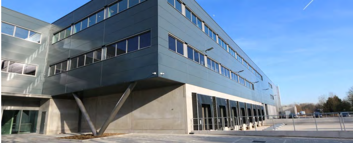
Montea «Space for Growth» - Site Zuid IV Erembodegem - Movianto (BE)
