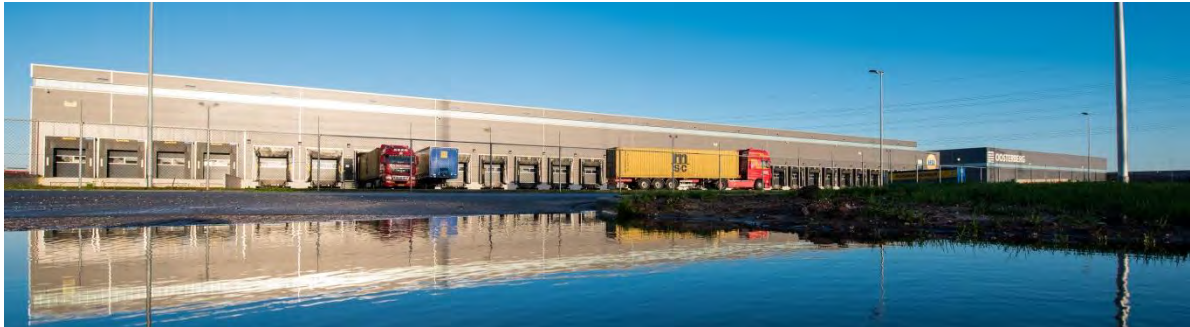
Montea «Space for Growth» - Site Apeldoorn - HSL (NL)
