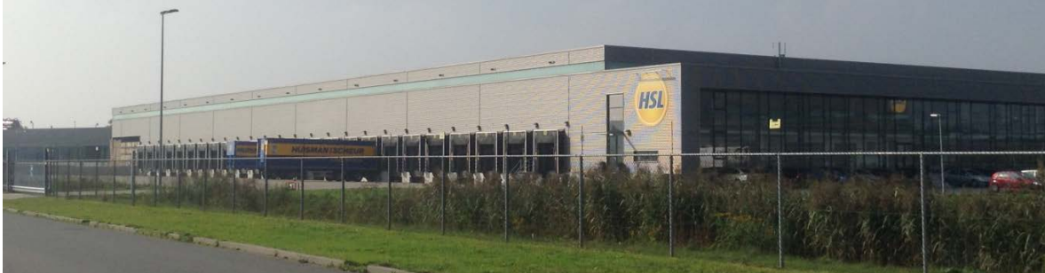
Montea «Space for Growth» - Site Apeldoorn - HSL (NL)
