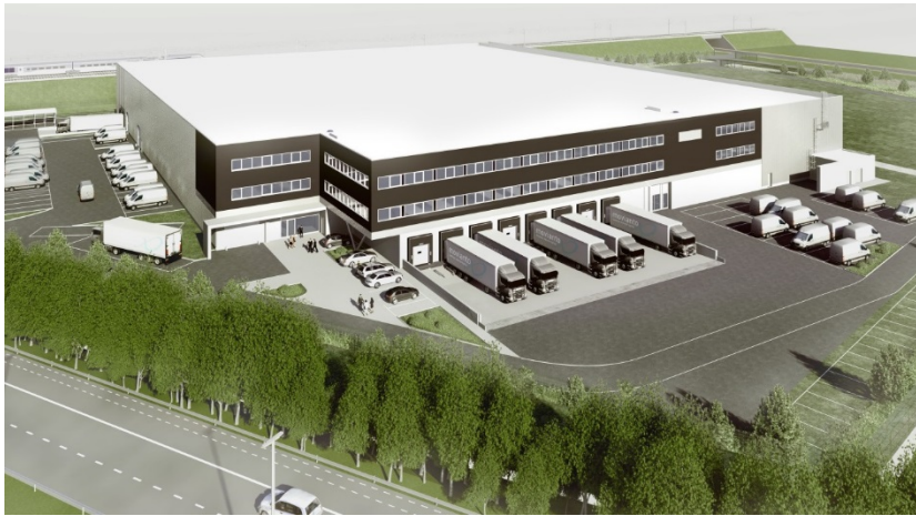
Montea «Space for Growth» - Site Zuid IV Erembodegem - Movianto (BE)
