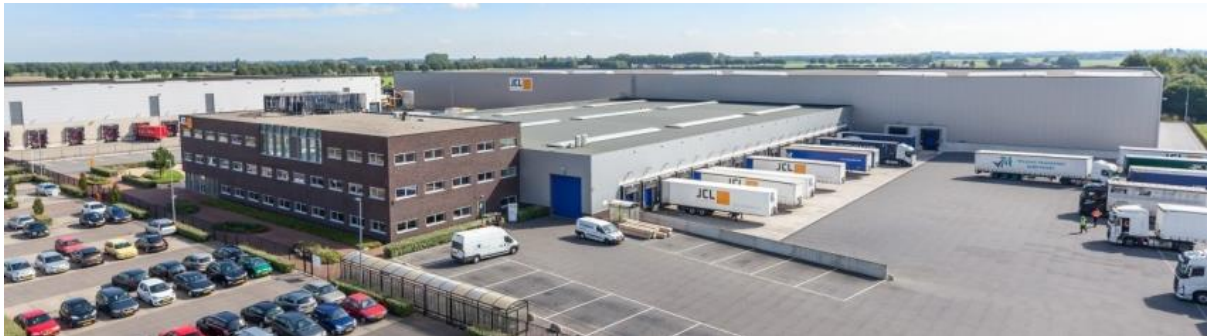
Montea « Space for Growth » - site de 's-Heerenberg (NL)
