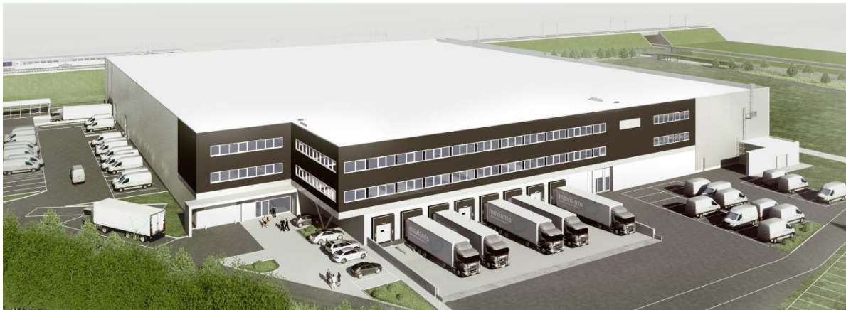
Montea « Space for Growth » - Site Zuid IV Erembodegem - Movianto (BE)
