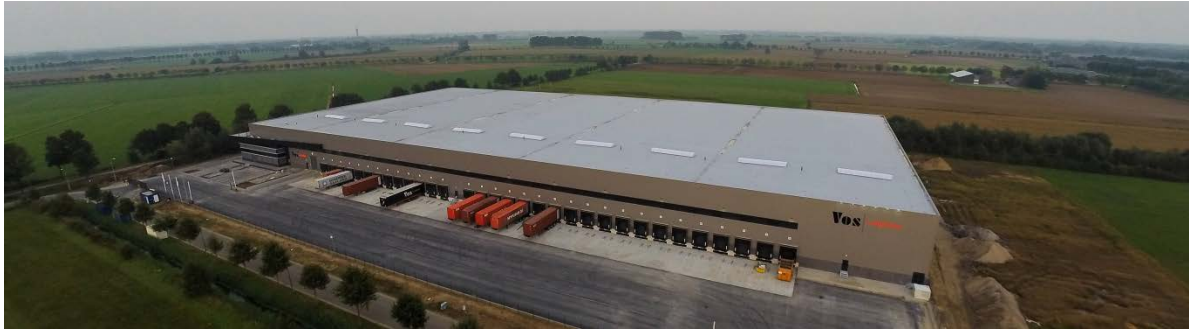
Montea «Space for Growth» - site Oss (NL)
