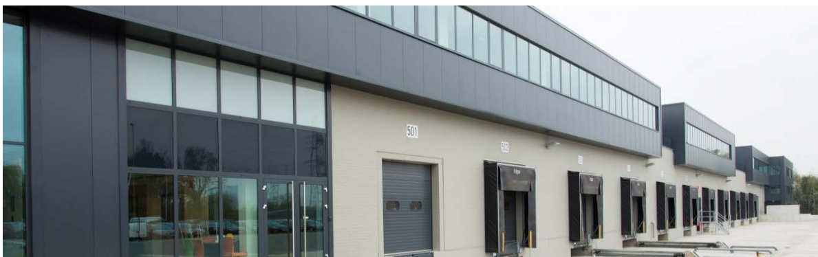
Montea «Space for Growth» - site Grimbergen (BE)
