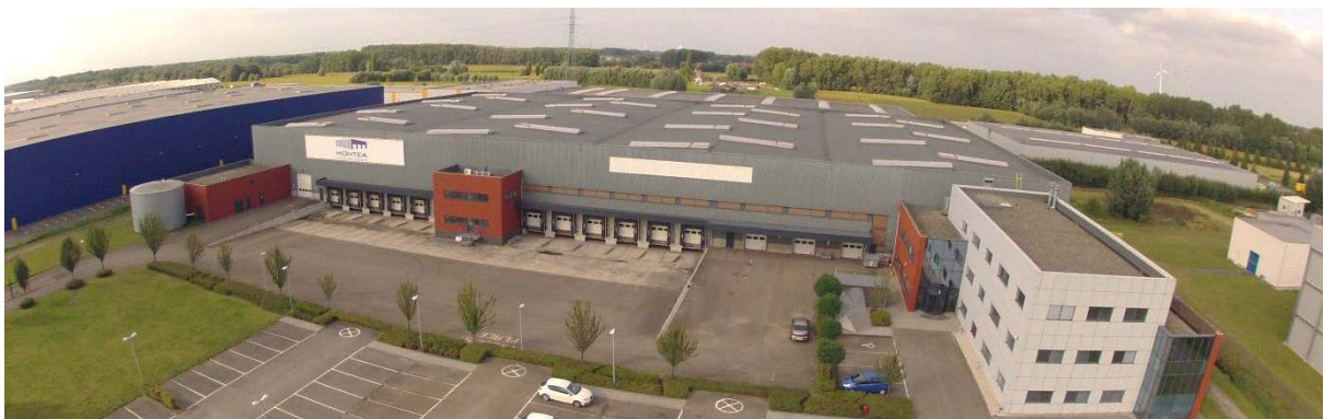
Montea «Space for Growth» - Site Puurs Schoonmansveld 28
