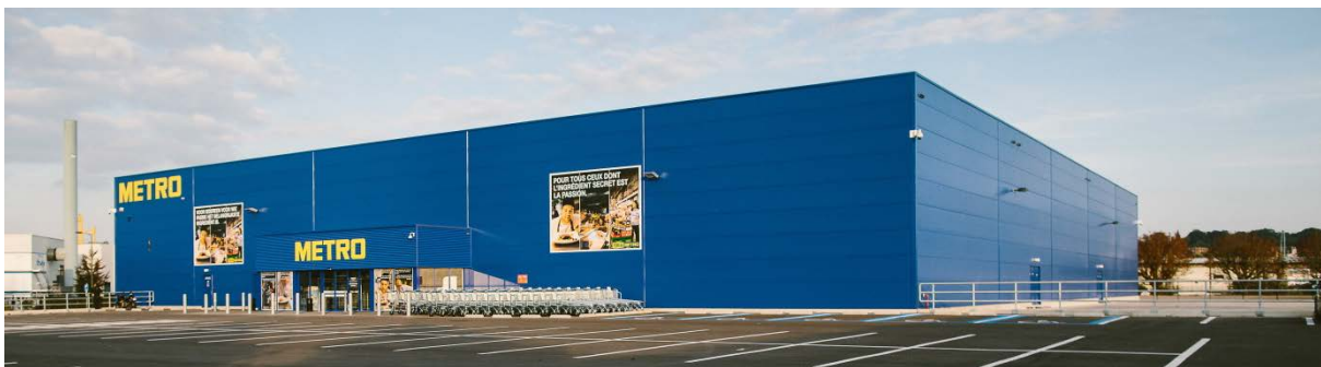
Montea «Space for Growth» - site de Forest - Metro (BE)
