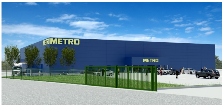
Montea «Space for Growth» - site de Forest - Metro (BE)
