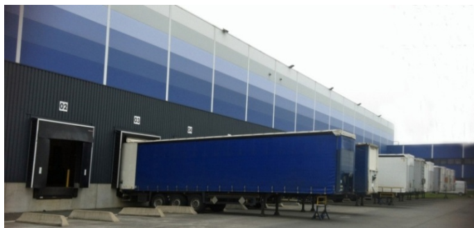
Montea «Space for growth» - Site Saint-Laurent-Blangy - Arras (FR)
