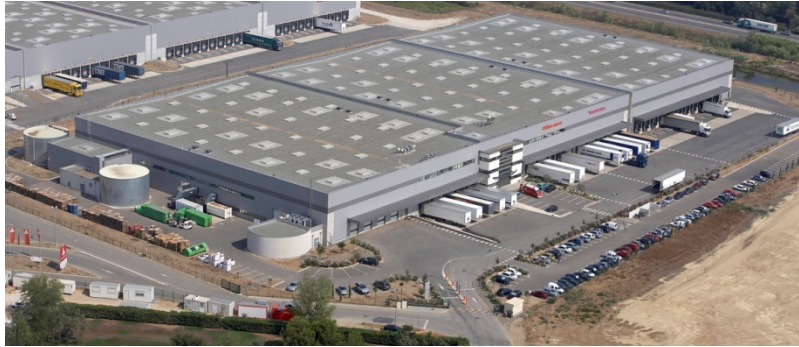
Montea «Space for Growth» - Site Saint-Martin-de-Crau (FR)
