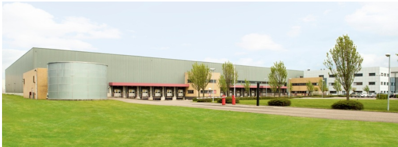
Montea «Space for Growth» - Site Puurs Schoonmansveld 58
