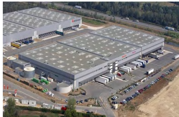
Montea « Space for Growth » - Site Saint-Martin-de-Crau (FR)
