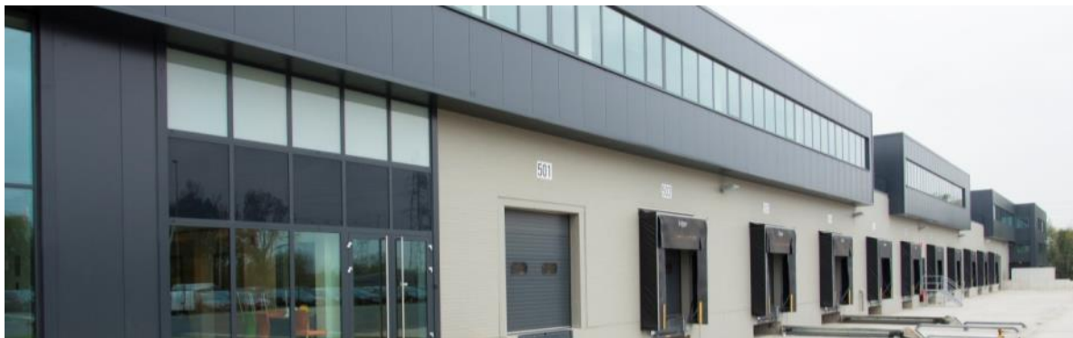
Montea «Space for Growth» - site Grimbergen (BE)
