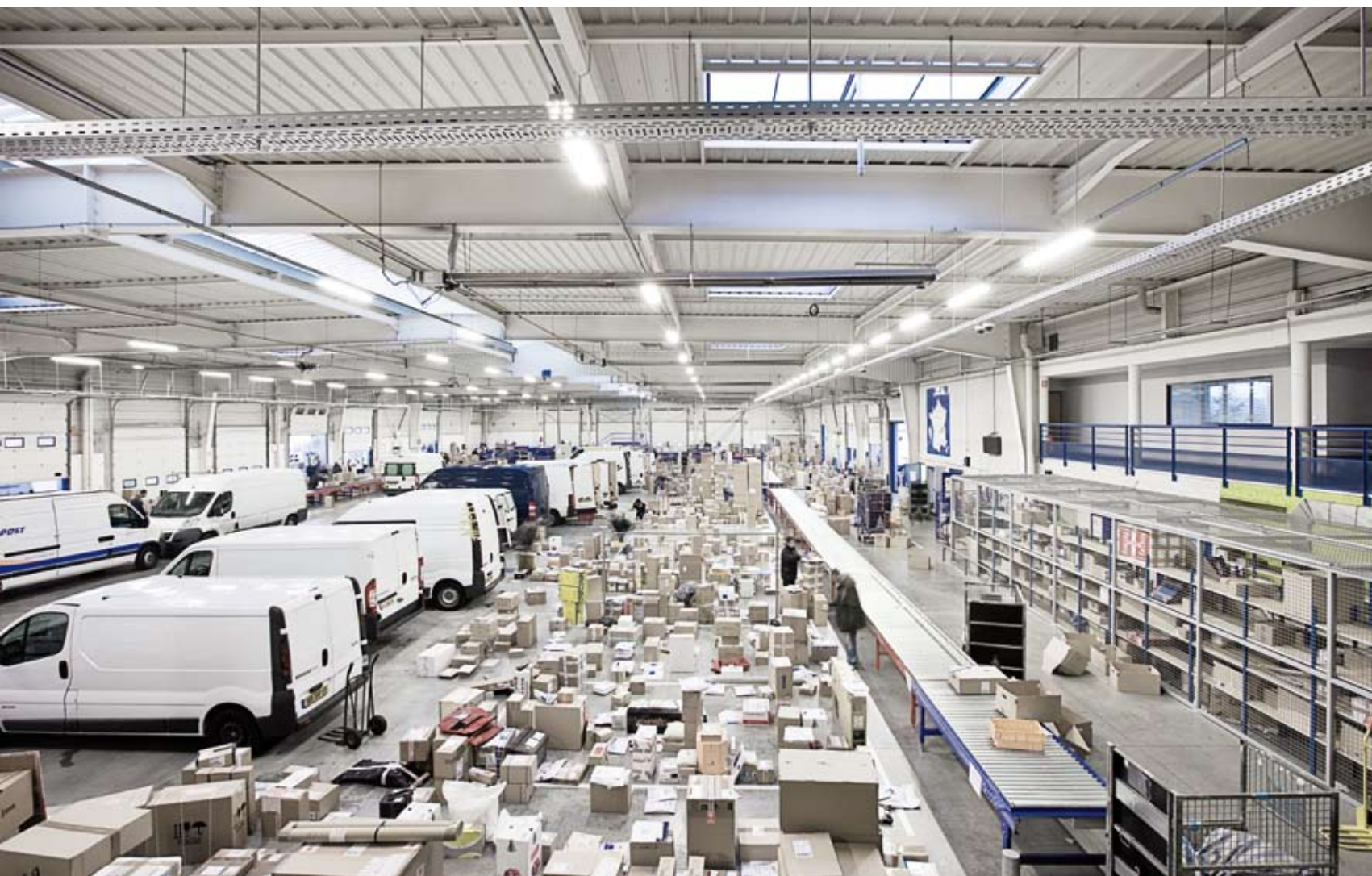
Site Montea / Décines (Lyon) (France) _ 3,821 m 2
