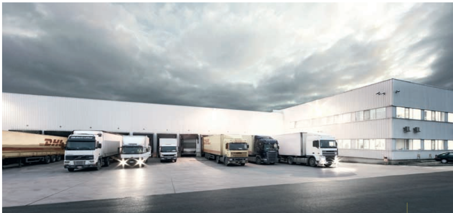
Site Montea / Grimbergen (België)
