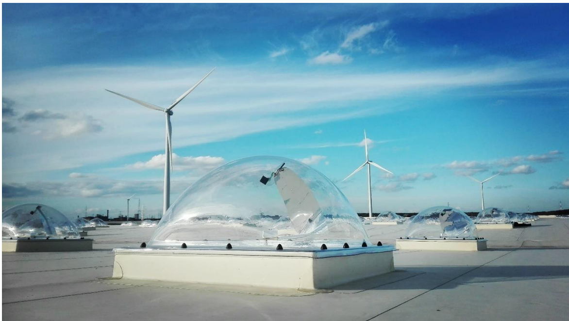
Afbeelding: Montea site te Bilzen verhuurd aan Carglass
