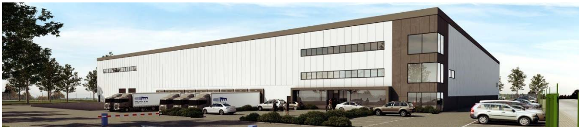
Montea «Space for Growth» - Nieuw luchtvrachtgebouw voor SACO Groupair - Brucargo (BE)
