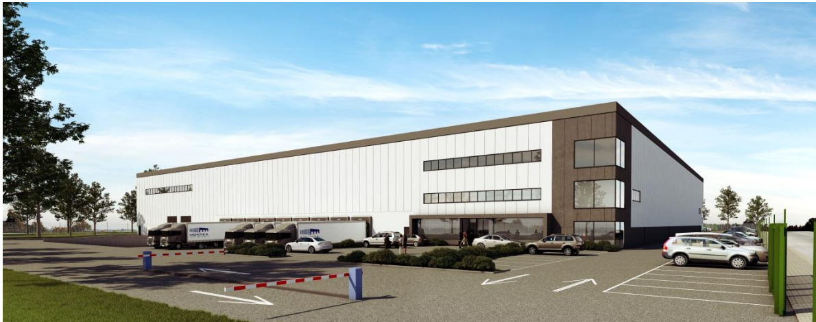
Montea «Space for Growth» - Nieuw luchtvrachtgebouw voor SACO Groupair - Brucargo (BE)
