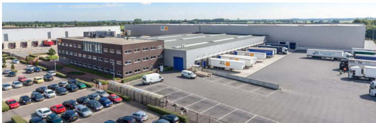
Montea «Space for Growth» - site de 's-Heerenberg (NL)
