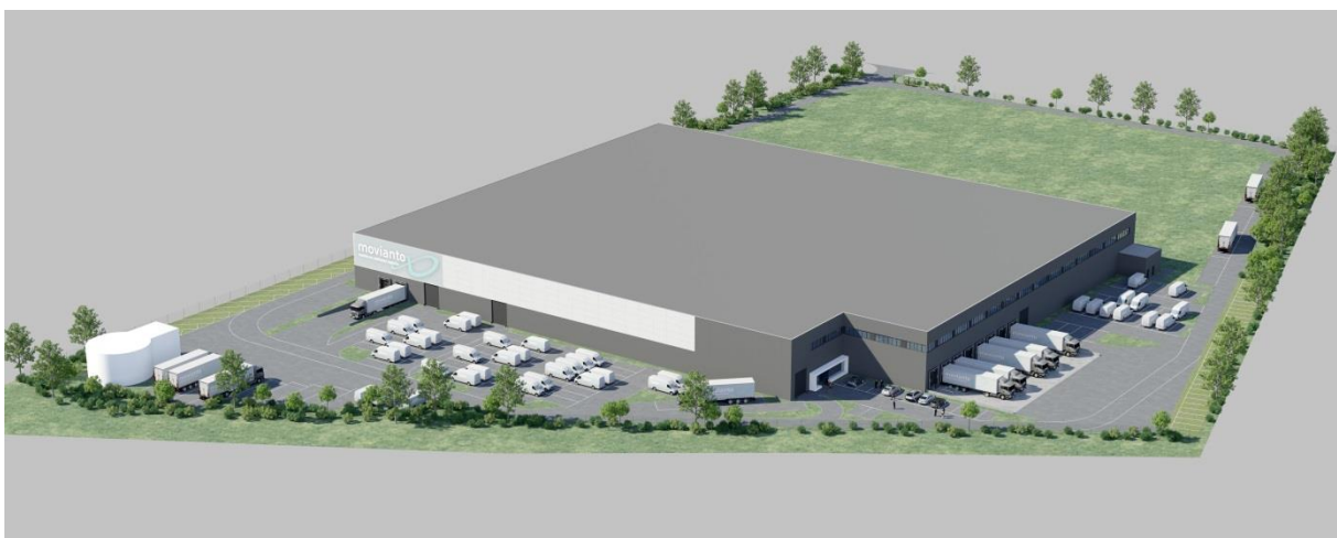
Montea «Space for Growth» - Site Movianto – Industriezone Zuid IV te Erembodegem (BE)
