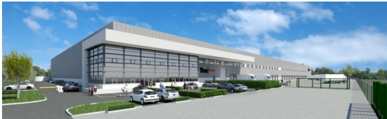
Montea «Space for Growth» - site Oss (NL)
