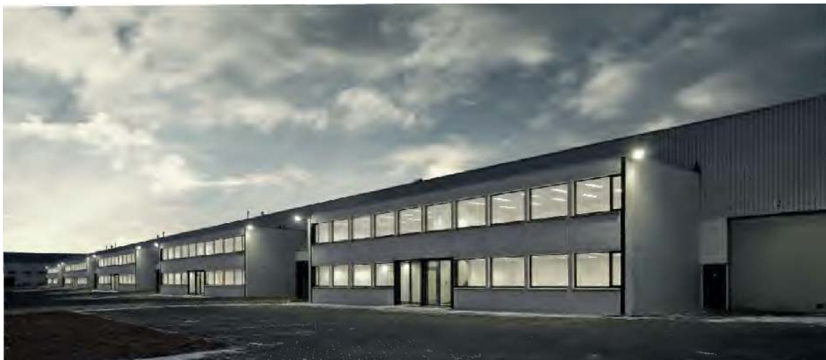
Montea « More than warehouses » - site Bornem (Belgium)
