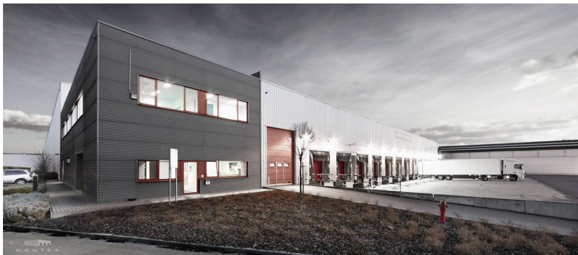
Montea « More than warehouses » - site Trangel-Aalst
