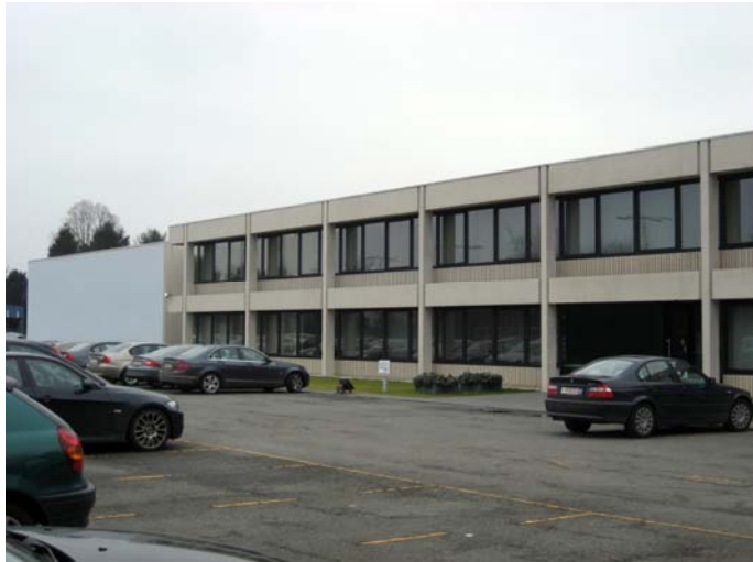
Site Erembodegem-Aalst (België)
